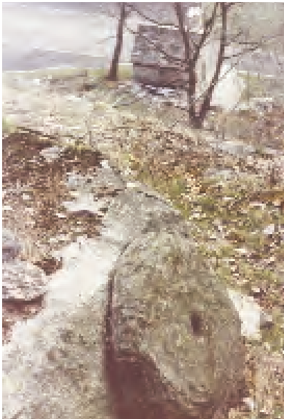
Oben: Reste der oberen Calonicheser Mühle. Unten: Portal mit Inschrift und Jahreszahl 1813. Zustand 1992.
