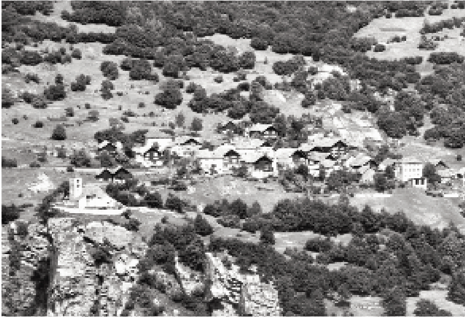
Links: Luftaufnahme der Siedlung mit der Kirche San Martino, um 1965. (Foto W. Borelli, Airolo)
